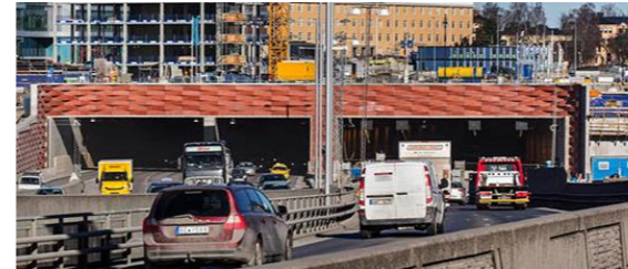
Norra länken tunnel & escape tunnels
